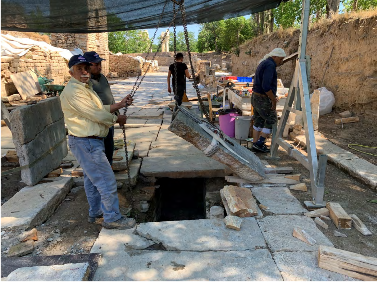
Resim 51: Alan konservasyonu. Tetrapylon Caddesi döşeme taşlarının onarımı (2022).
