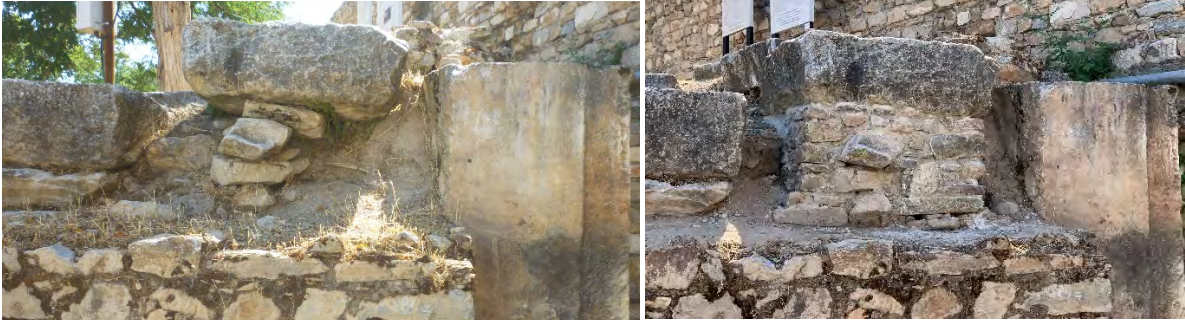
Figs. 48-49: Sebasteion, Tapınak. Tapınak podyumunun güneybatı köşesi, solda yıpranmış temeller, sağda tamirat sonrası görünümü (2021)
