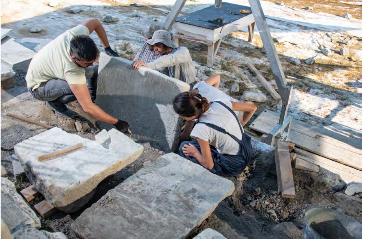
Res. 44: Güney Agora – Palmiye Parkı. Havuz çerçevesinin iç kısmındaki ayak koyma levhalarının kaldırılması ve tamirâtı (2018).
