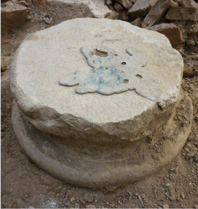
Res. 7: Tetrasyon Caddesi. Sütun kaidesinin üst kısmı, sütunun tam oturması amacıyla kaideyi düzleştirmek için dökülüp donmuş kurşun.
