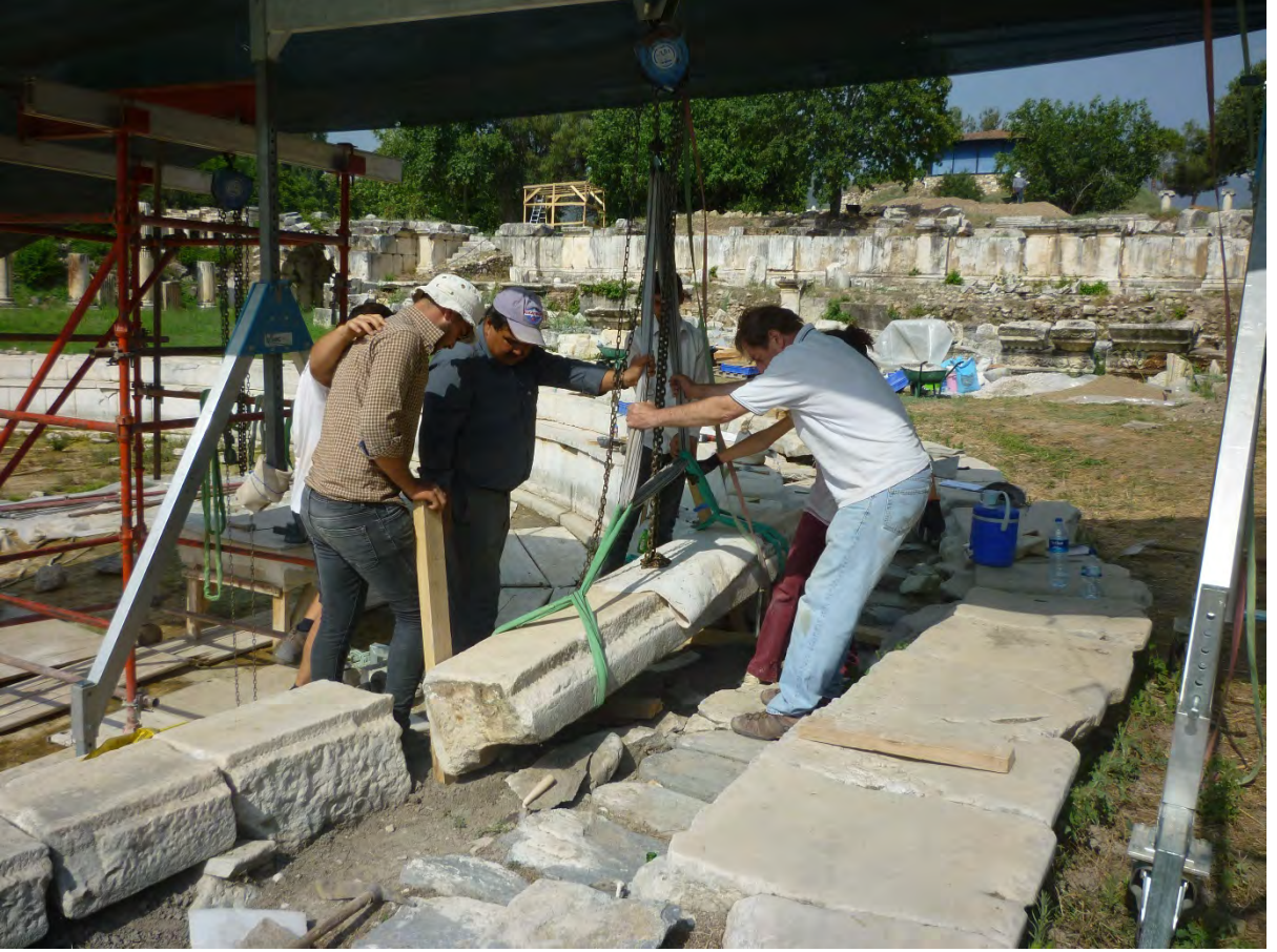
Res. 43: Güney Agora – Palmiye Parkı. Havuz çerçevesinin iç kısmındaki oturma bloklarının kaldırılması ve tamirâtı (2018).
