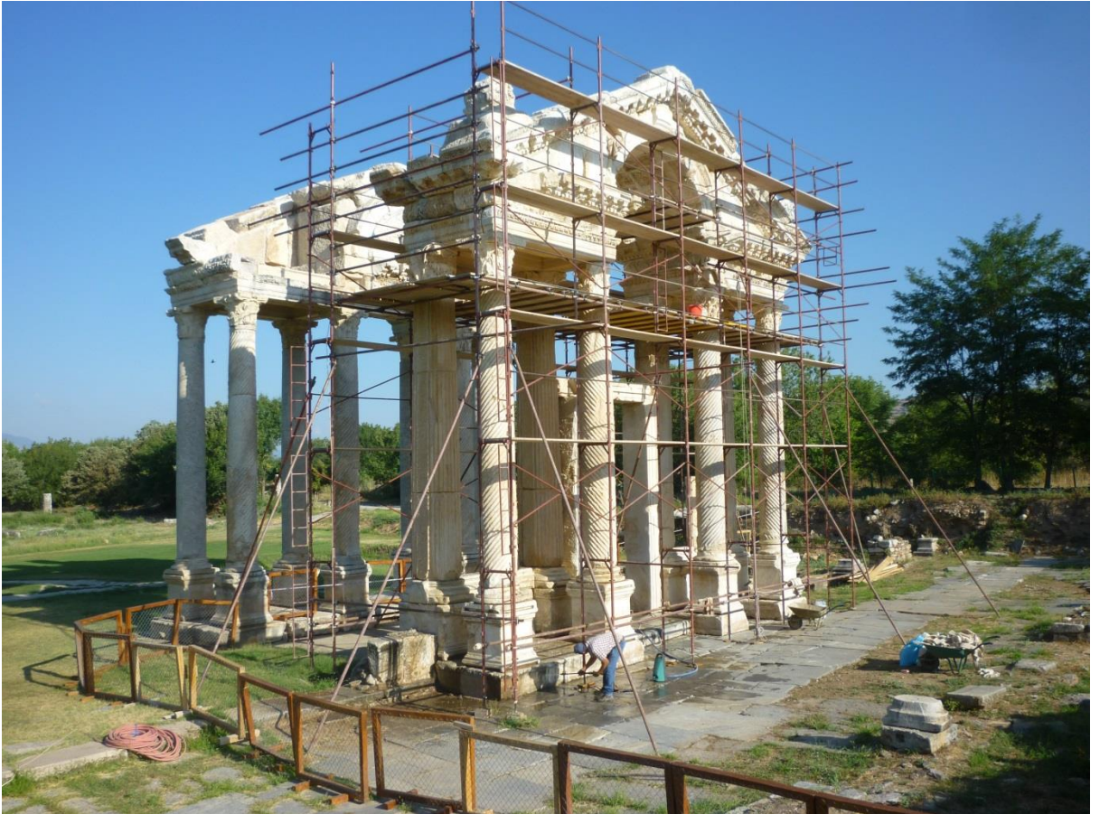
Resim 11: Tetrapylon'un doğu tarafına kurulan iskele ve yapı koruma çalışmaları (2017).
