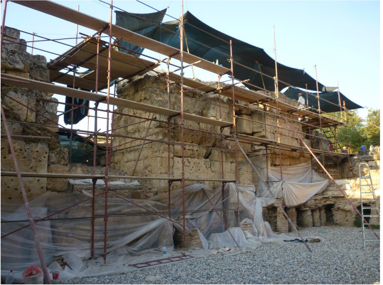
Res. 4: Hadrian Hamamı, Oda 4 ve 5 arasındaki duvarda restorasyon çalışmaları (2016).
