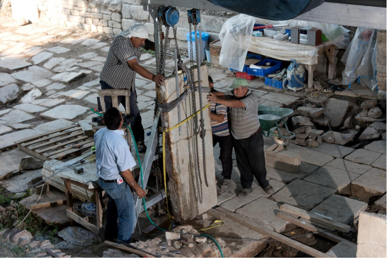
Res. 10: Tetrasyon Caddesi, döşeme taşları ve drenaj kapaklarının restorasyonu (2016).
