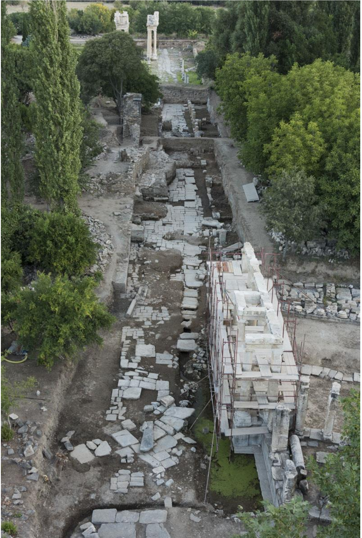
Res. 27 Tetrapylon Caddesi, Açma 15.1 kazısı, güneyden görünüm (2015).
