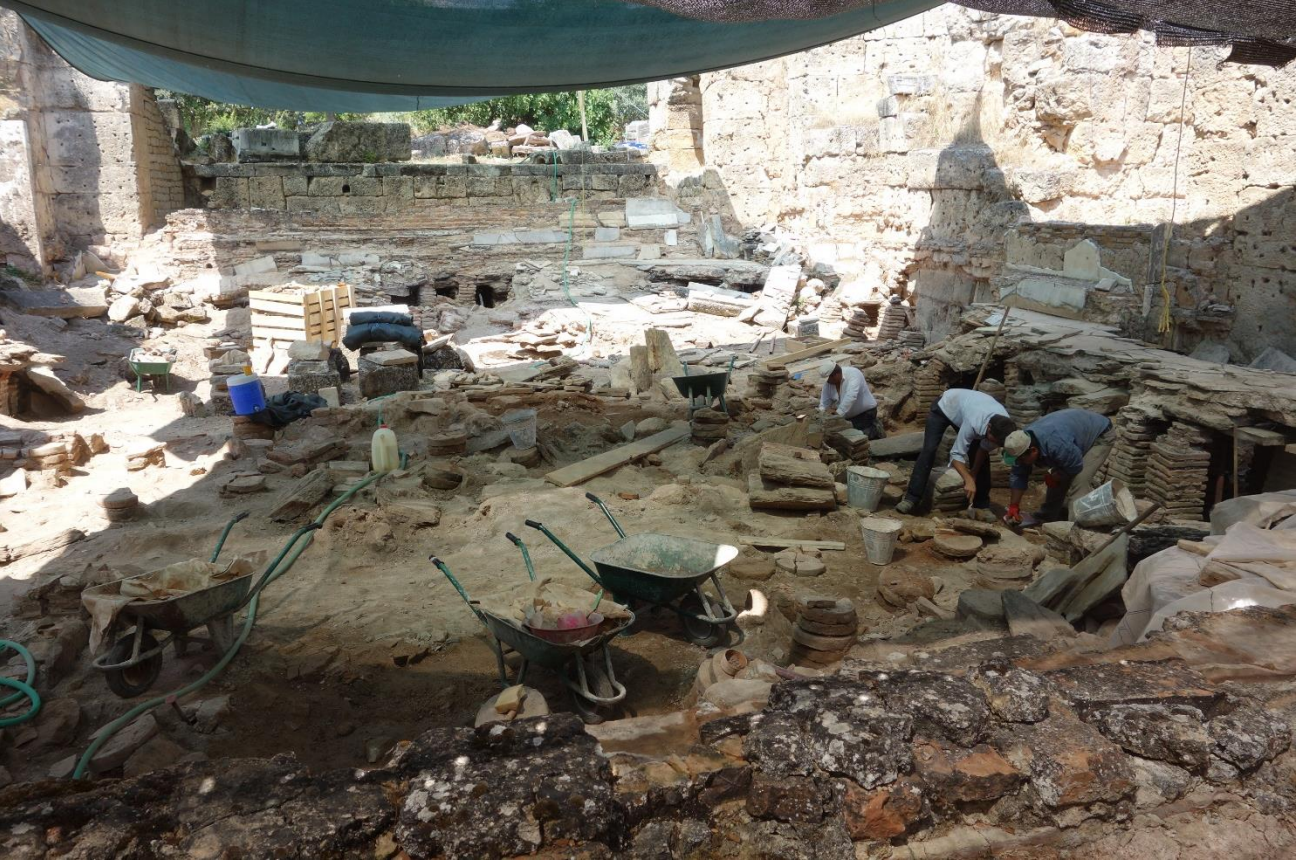
Res. 3 Hadrian Hamamı, Oda 4, 2015 restorasyon çalışmaları. Batıya bakış.
