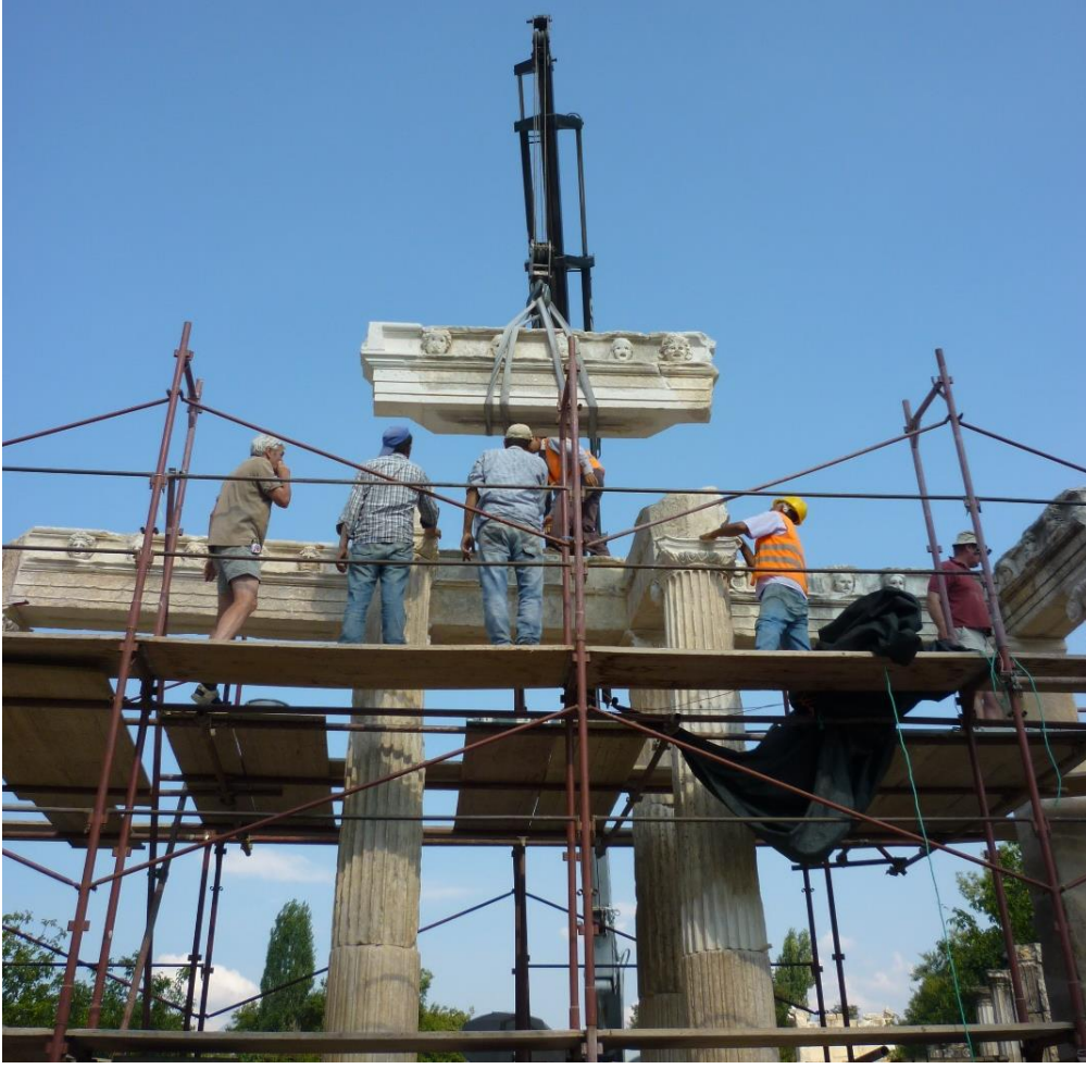
Res. 14 Sebasteion Propylon. Anastylosis: arşitrav-friz bloęu yerine yerleřtirilirken (2015).
