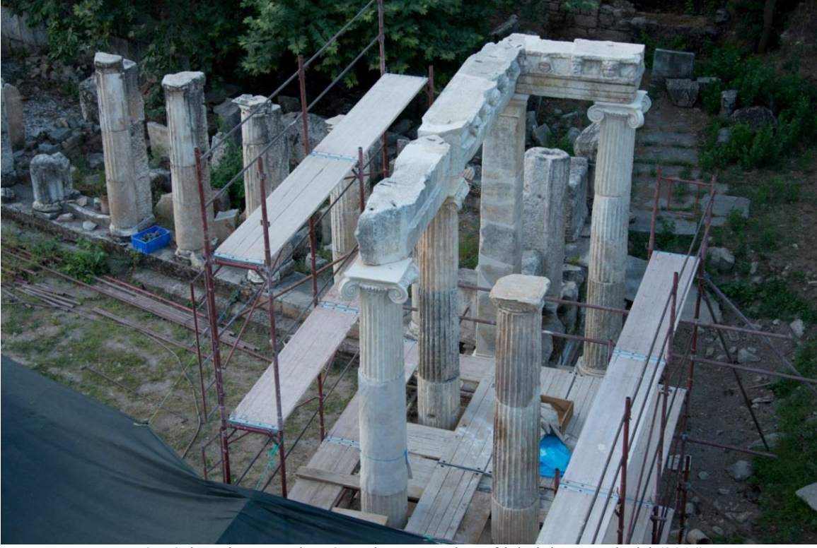
Res. 27: Sebasteion Propylon. Sütunların ve arşitrav frizlerinin anastylosisi (2014).
