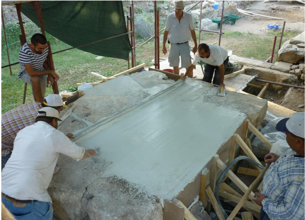
Res. 28: Sebasteion Propylon. Kuzey aedikula'nın temel ve stilobatının sağlamlaştırılması (2014).
