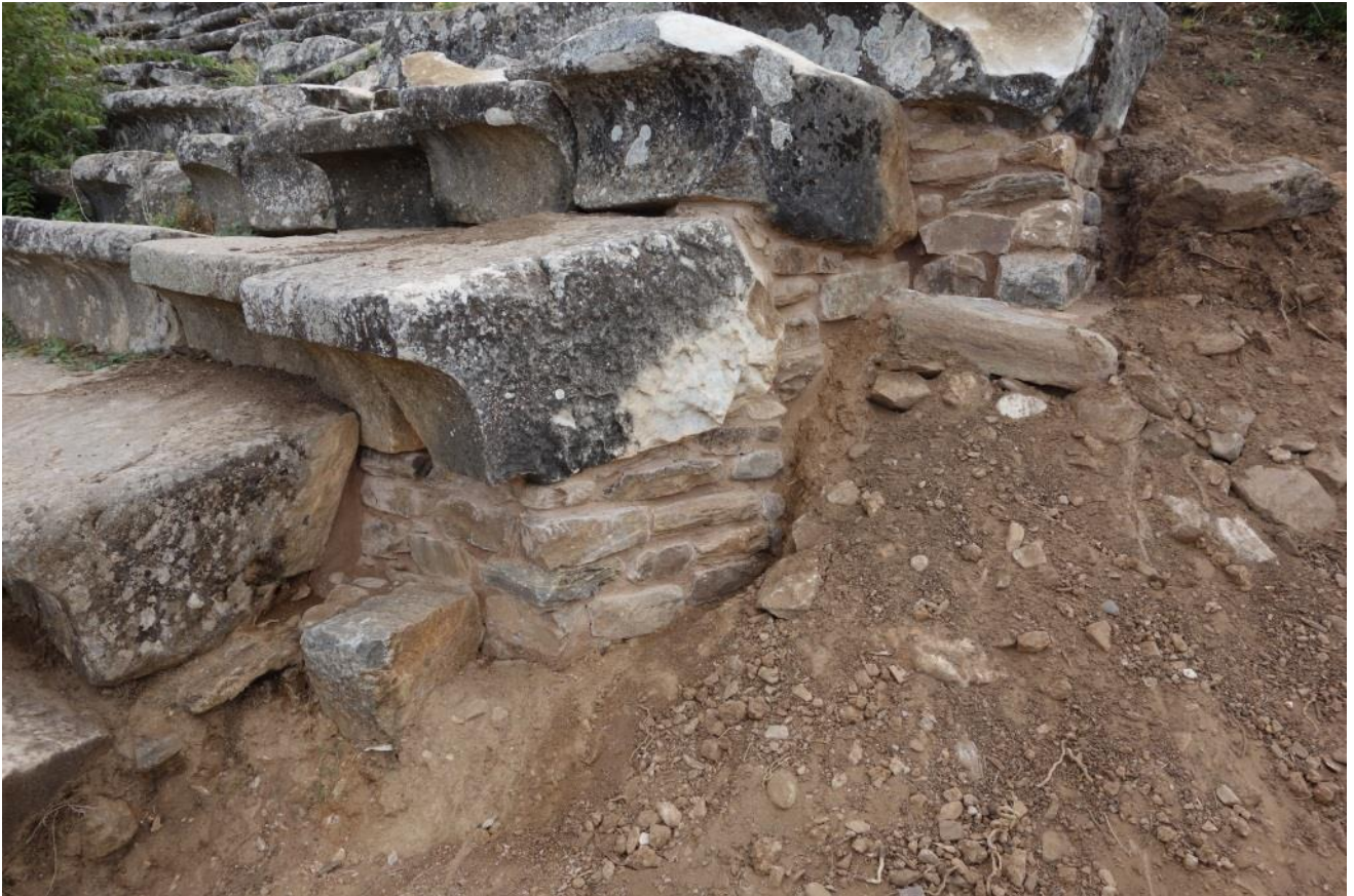
Res. 17-18: Stadyum. Dođu giriřindeki mermer oturma sırası onarılmıřtır (2014).
