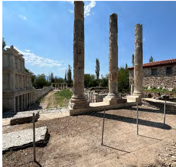
Resim 53 A-B: Sebasteion Tapınak. A: Restore edilen cephenin temelini podyuma bağlamak için yapılan takviyenin kesidi ve planı. B: Güçlendirme sonrası Tapınak sütunlarının anastylosisi, batıya bakış (2024).
