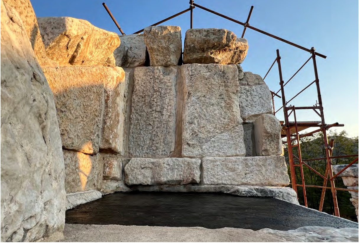
Resim 48: Tetrapylon. Batı taraf. Cephenin kuzey yüzünün arkasında, korniş seviyesinin üzerinde ISONEM BE 89 ile kapatılan bağlantı noktaları ve izolasyon, kuzeye bakış (2024).
