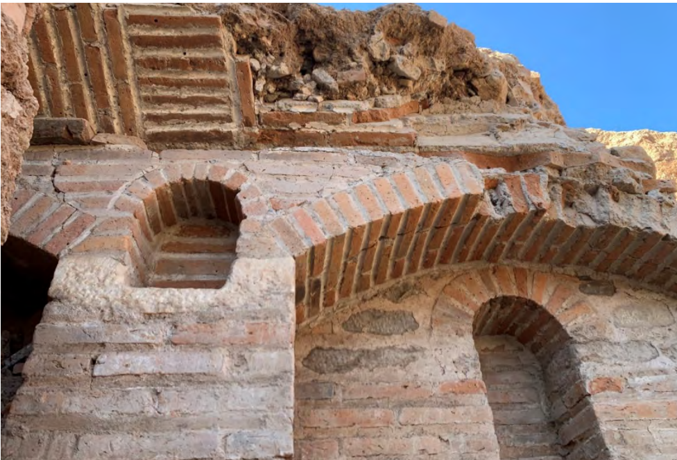
Resim 12: Kybele Evi. HoK 24.2, Oda 12, kuzey duvar, tuğlaları, nişleri ve tonozu gösteren detay (2024).
