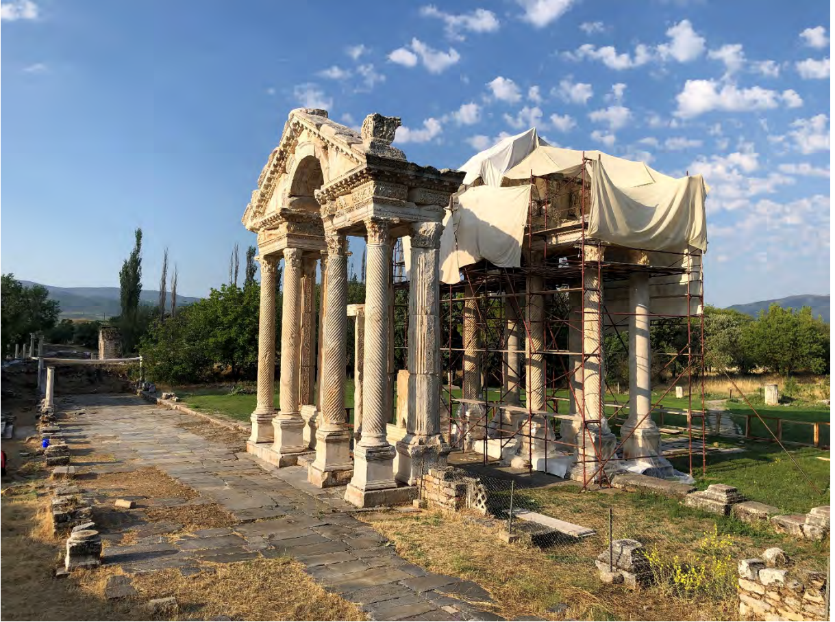
Resim 47: Tetrapylon. Konservasyon ve bakım çalıřmaları için yapının batı tarafına kurulan iskele (2024).
