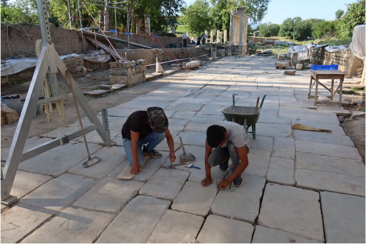
Resim 45: Tetrapylon Caddesi. Cadde zemin kaplamasının tamiri, kuzeyden görünüm (2023).
