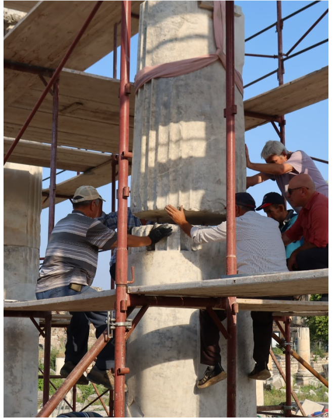
Resim 10A-B: Bazilika. Vestibüle ait büyük boyutlu çifte yarım sütunların anastylosis çalışmaları (2023).
