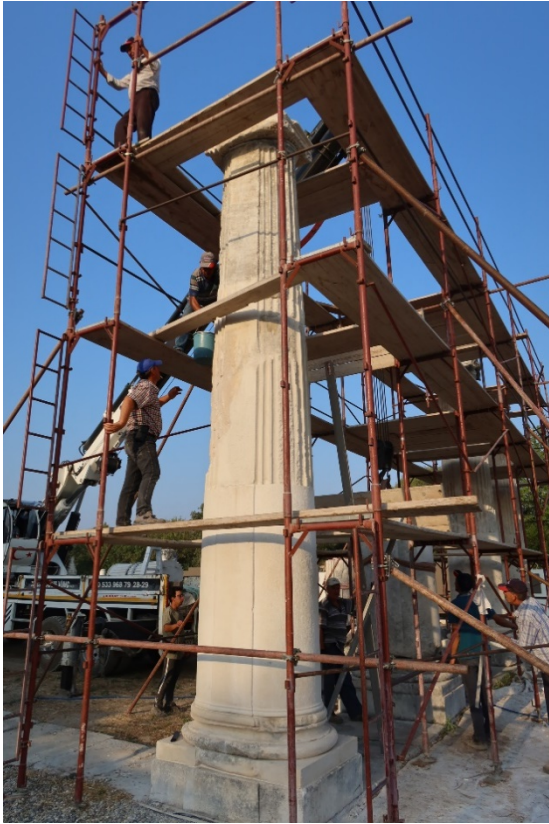
Resim 10A-B: Bazilika. Vestibüle ait büyük boyutlu çifte yarım sütunların anastylosis çalışmaları (2023).
