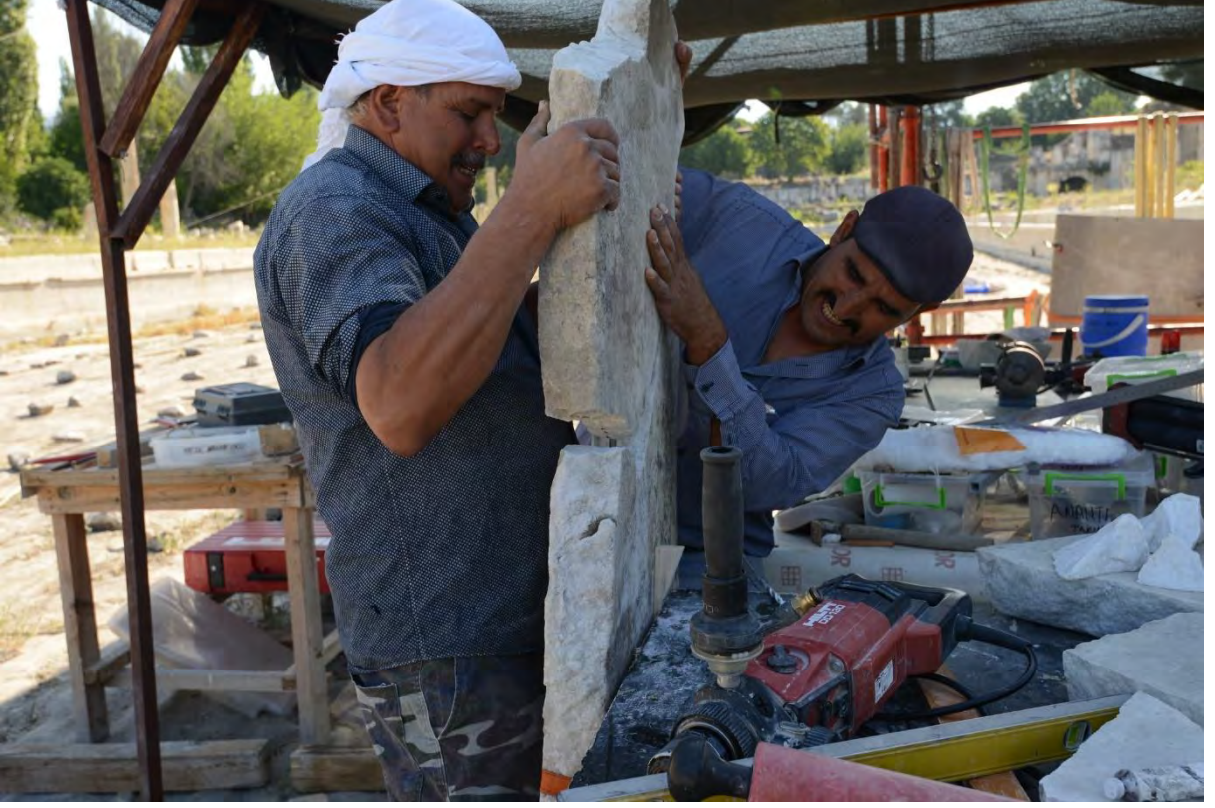
Resim 21: Güney Agora / Palmiye Parkı. Havuz çerçevesine ait ayak levhasının konservasyonu (2019).
