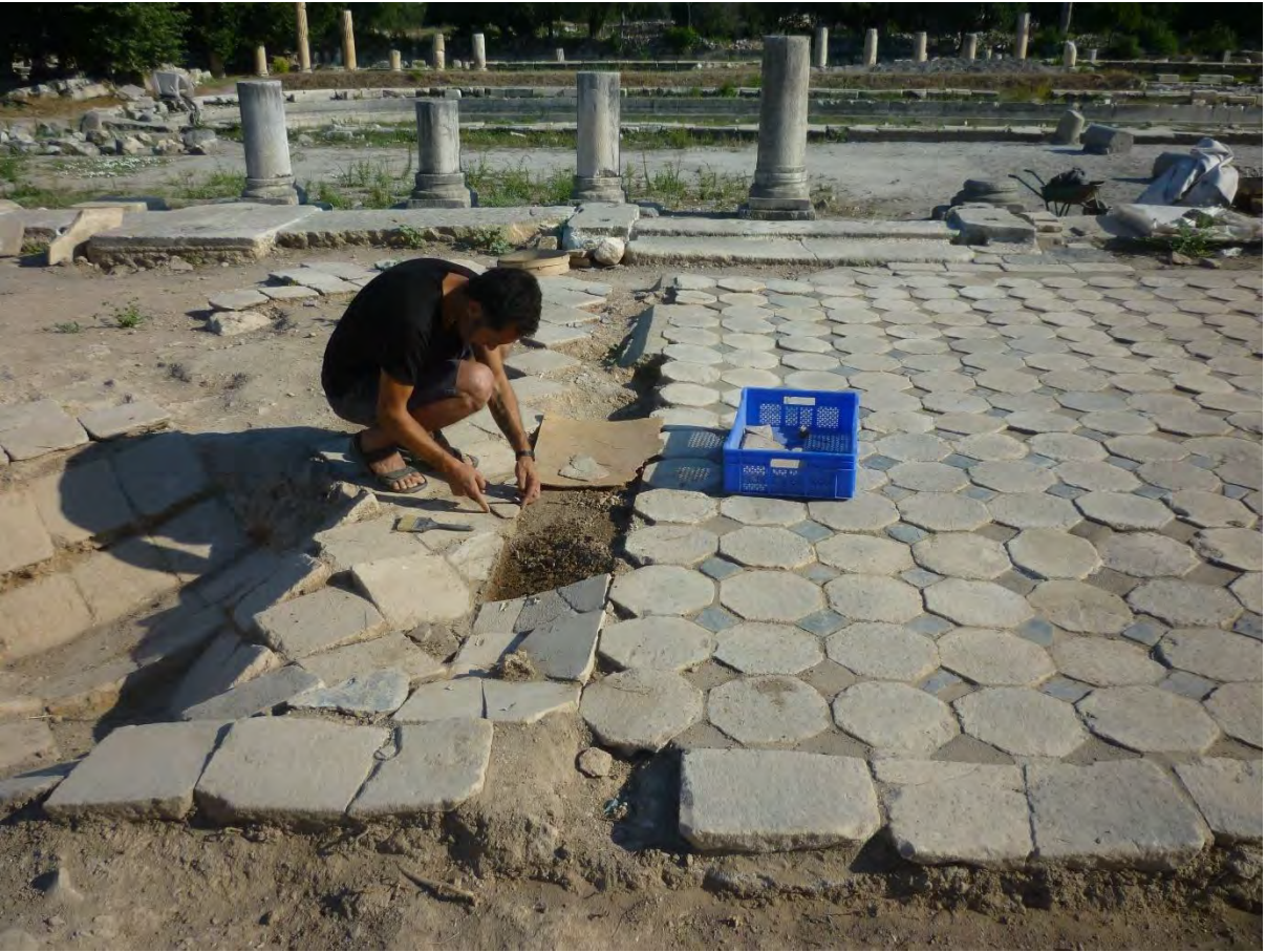
Resim 10: Bazilika. Vestibüldeki mermer döşemeli tabanın restorasyonu (2019).
