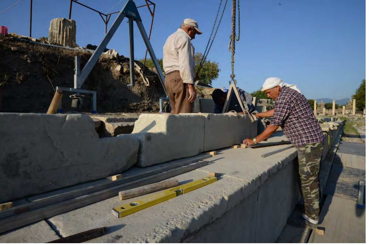
Resim 23: Güney Agora / Palmiye Parkı. Havuz çerçevesinin iç oturma bloklarının konservasyonu, güney tarafı (2019).
