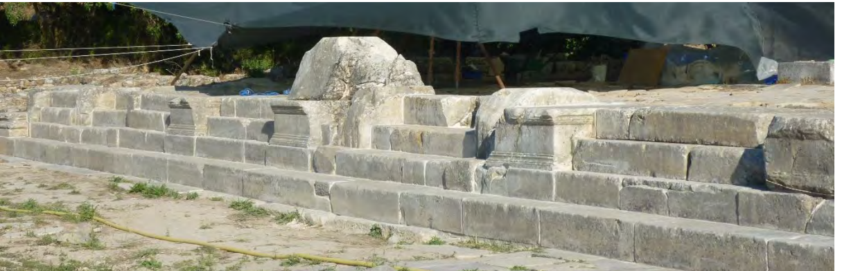
Resim 14a-b: Bazilika'nın ön cephesine ulaşan basamaklı giriş, konservasyon esnasında ve sonrasında (2019).
