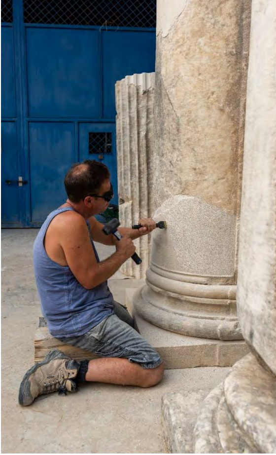
Resim 15: Bazilika. (a) Sütunun eksik parçası yerine konulan yapay taşın elle yontulması. (b) Sütun tamburlarını yerleştirme denemesi.
