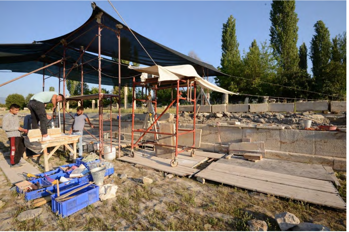
Resim 20: Güney Agora / Palmiye Parkı. Havuz çerçevesinin konservasyonu, güney taraf (2019).
