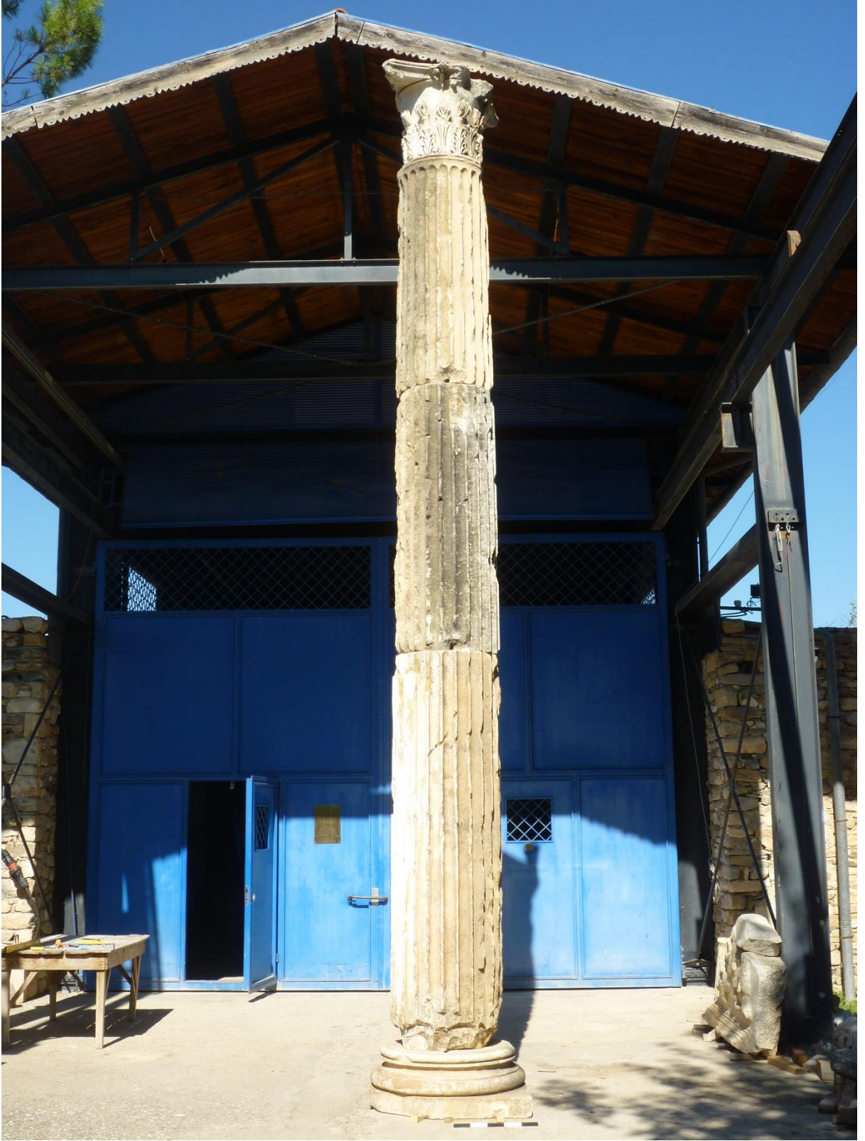
Res. 53: Sebasteion Tapınađı. Tapınađa ait sütünlardan birinin deneme olarak, konservasyon laboratuvarı (Mavi Depo) önünde ayađa kaldırılması (2018).
