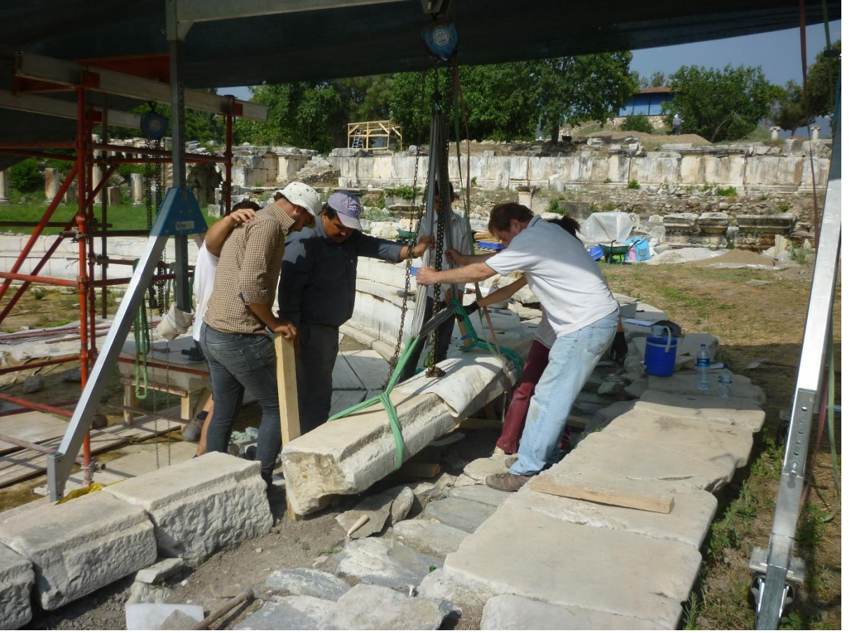
Res. 43: Güney Agora – Palmiye Parkı. Havuz çerçevesinin iç kısmındaki oturma bloklarının kaldırılması ve tamirâtı (2018).
