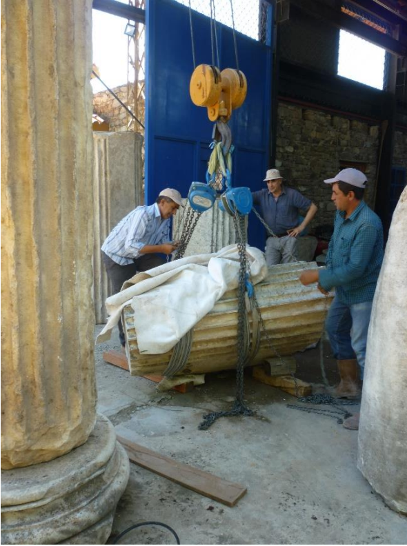
Figs. 34 - 35: Bazilika. Ön cepheye ait çiftli yarım sütunların konservasyon atölyesine (Mavi Depo) taşınması ve birleştirme denemeleri (2018).
