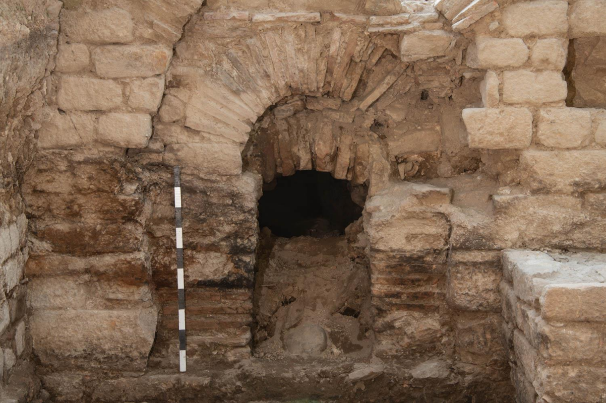
Res. 22: Tetrapylon Caddesi. Geç antik çağa ait praefurnium açıklığı Nişli Yapı'nın hemen güneyinde caddenin batı duvarına açılmıştır (2018)
