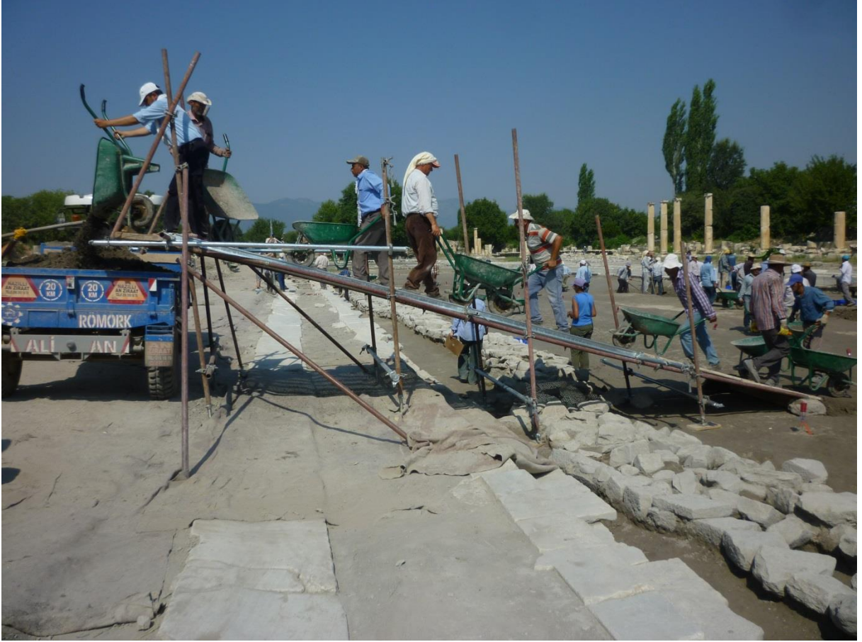
Resim 16: Güney Agora Havuzu kazısından çıkarılan toprağın bertarafı için kurulan çelik rampa (2017).
