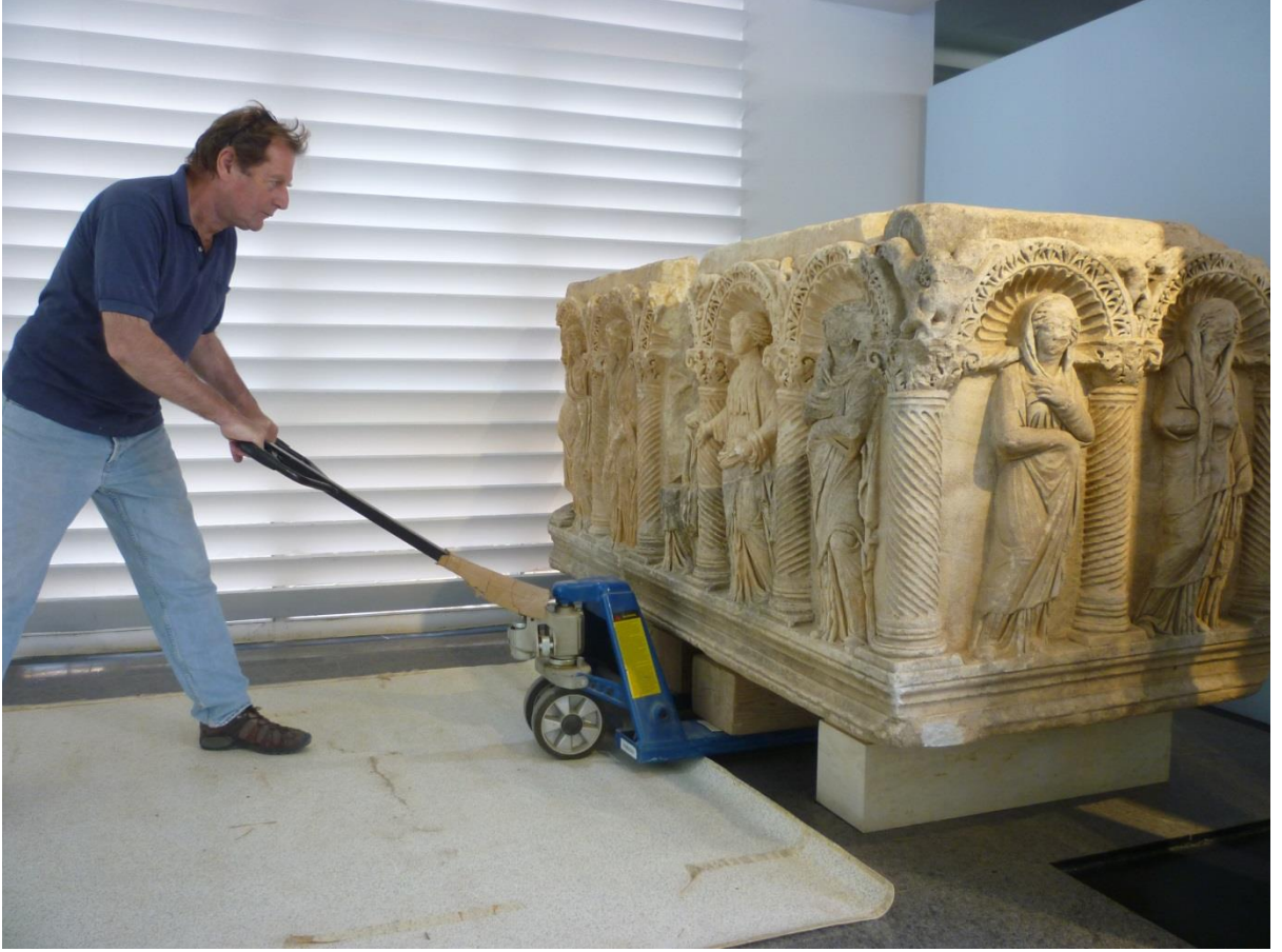
Resim 10: Aphrodisias Müzesi'nde lahit altına yeni destek taşları yerleştirme çalışmaları (2017).
