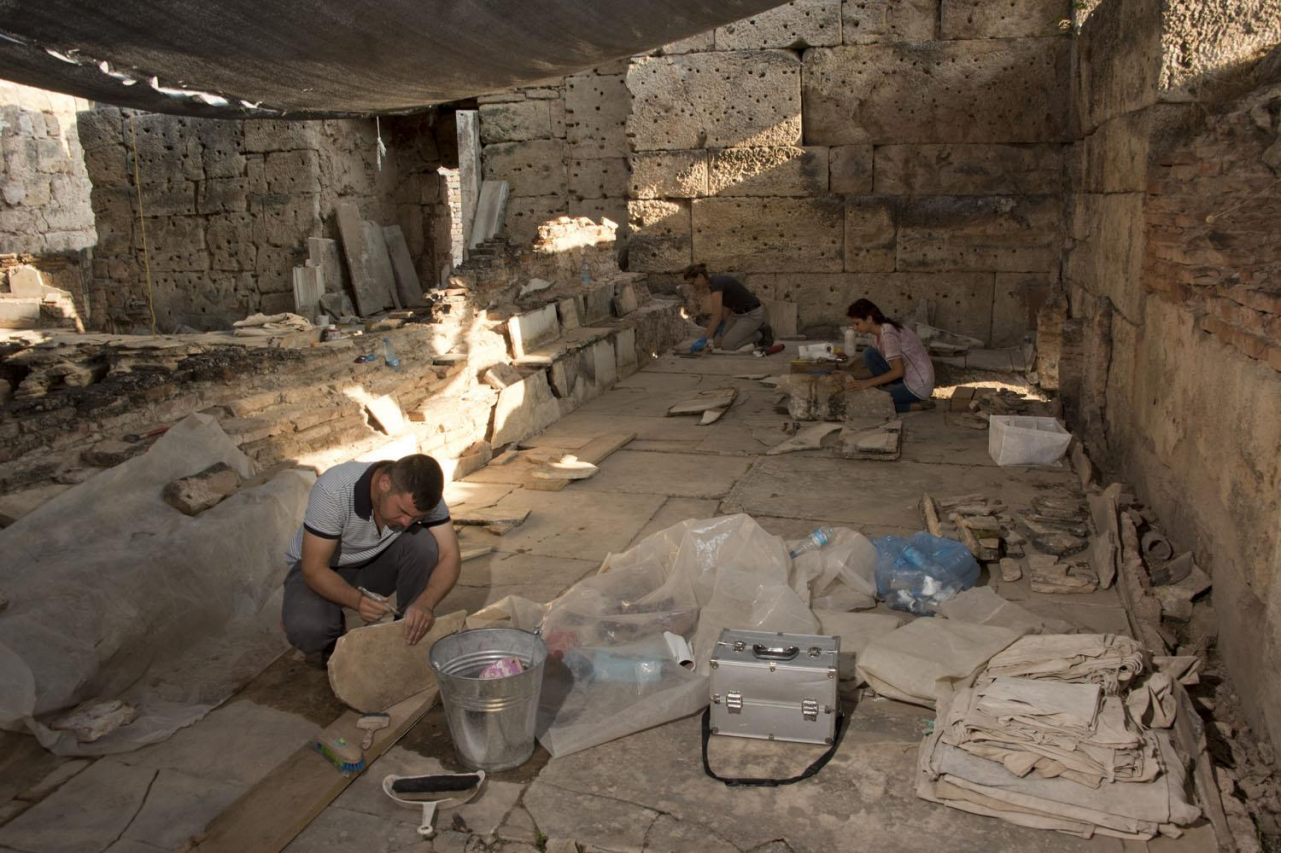
Res. 4 Hadrian Hamamı, Oda 4: dođu havuz mermer kaplamalarının restorasyonu (2015).
