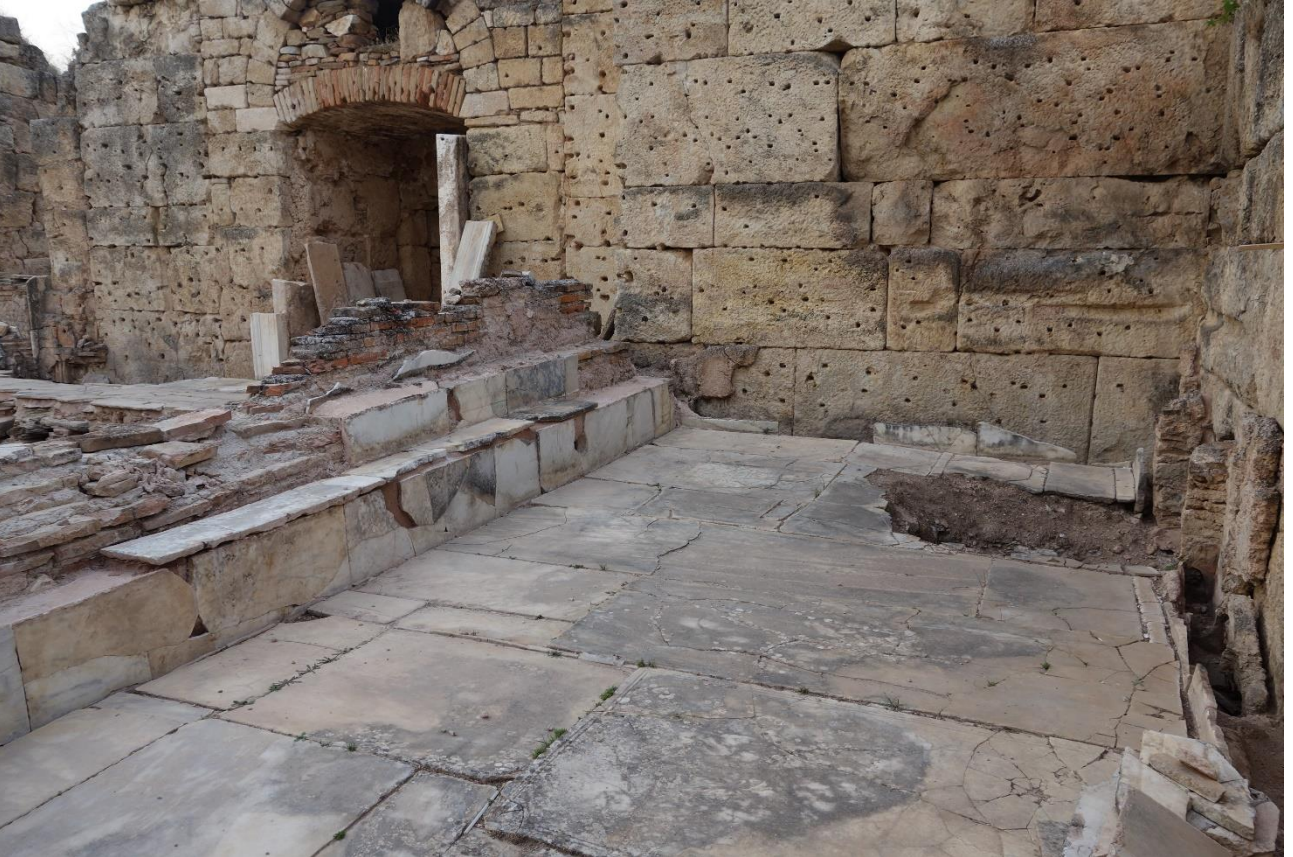
Res. 5 Hadrian Hamamı, Oda 4: dođu havuz mermer kaplamalarının restorasyonu sonrası (2015).
