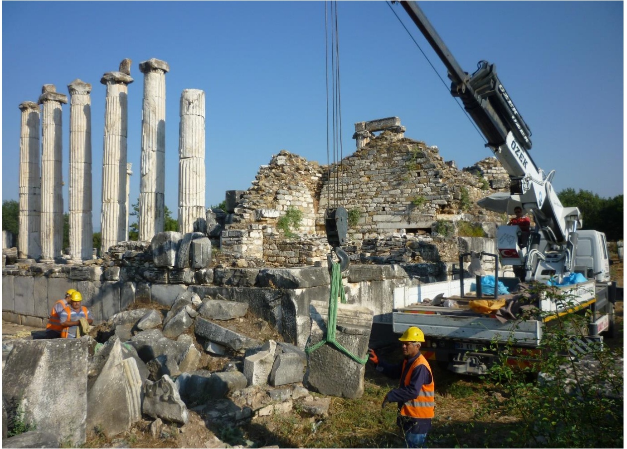
Res. 11 Tapınak-Kilise: Güneydoğu köşeden blokların taşınması (2015).
