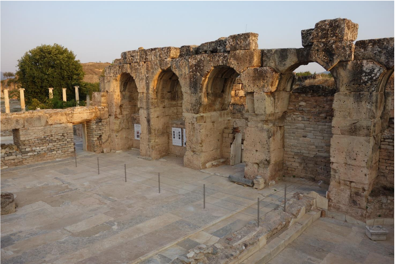
Res. 7 Hadrian Hamamı, Oda 6, restore edilen döşeme ve duvarlar ile ziyaretçi akımını düzenleyen çelik bariyerler (2015).
