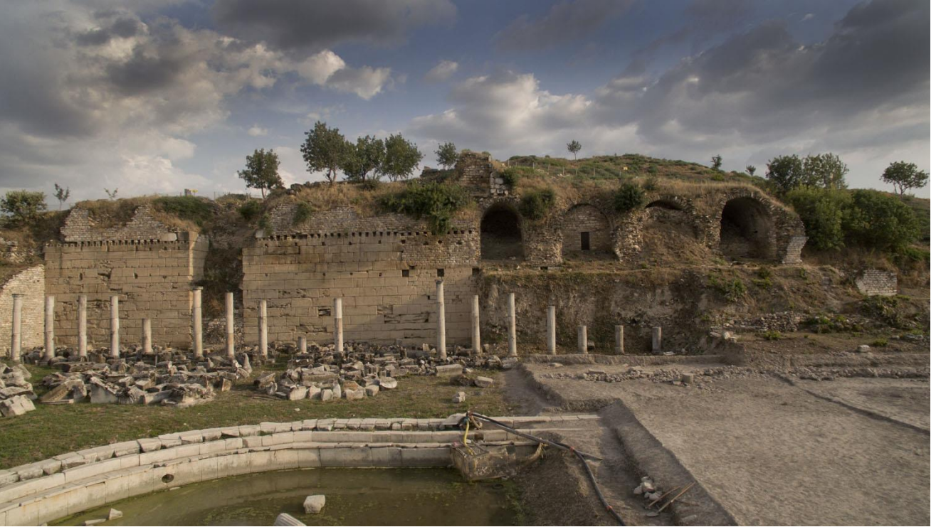
Res. 26 Güney Agora, güney portiko, Tiyatro istinat duvarı ve tonozları, kuzeyden görünüm (2105).
