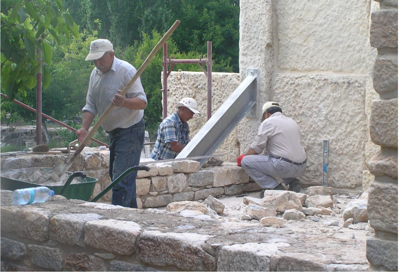
Res. 13 Sebasteion, Güney Yapı: İkinci İon katı arkasına çelik desteğin yerleştirilmesi (2015).
