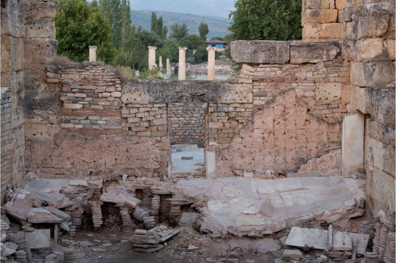
Res. 2-3: Hadrian Hamamı. Oda 5: çökmüş mermer döşeme ve hipokost'un onarımı (2014).
