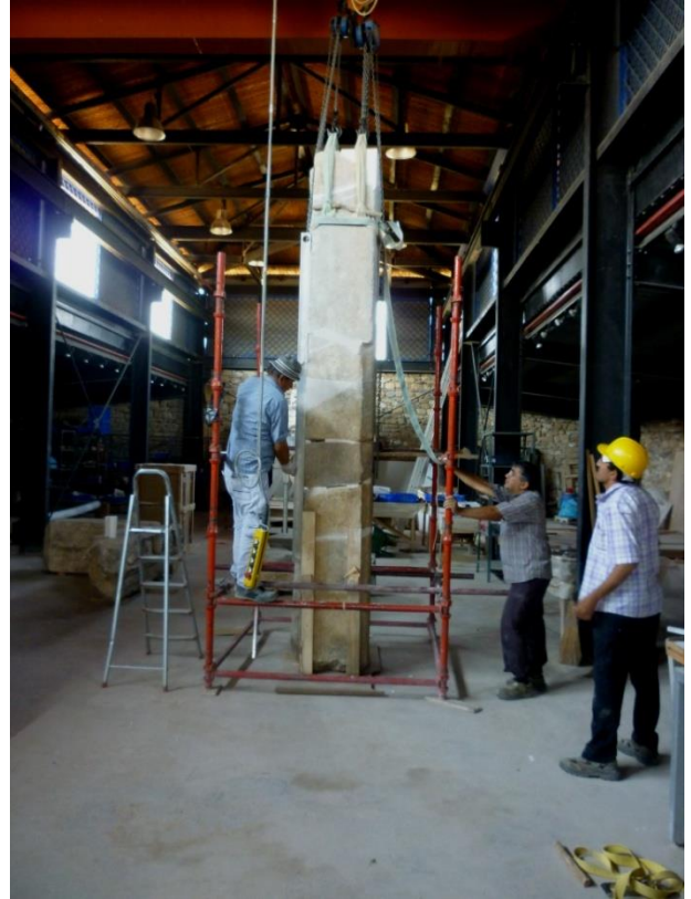
Res. 29-31: Sebasteion Propylon. Sütunların ve payelerin konservasyon işliğinde onarılması (2014).
