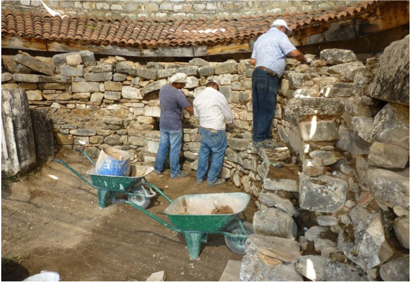
Res. 23: Afrodit Tapınađı. Kilisenin dođusundaki synthron kısmındaki restorasyon alıřması (2014).
