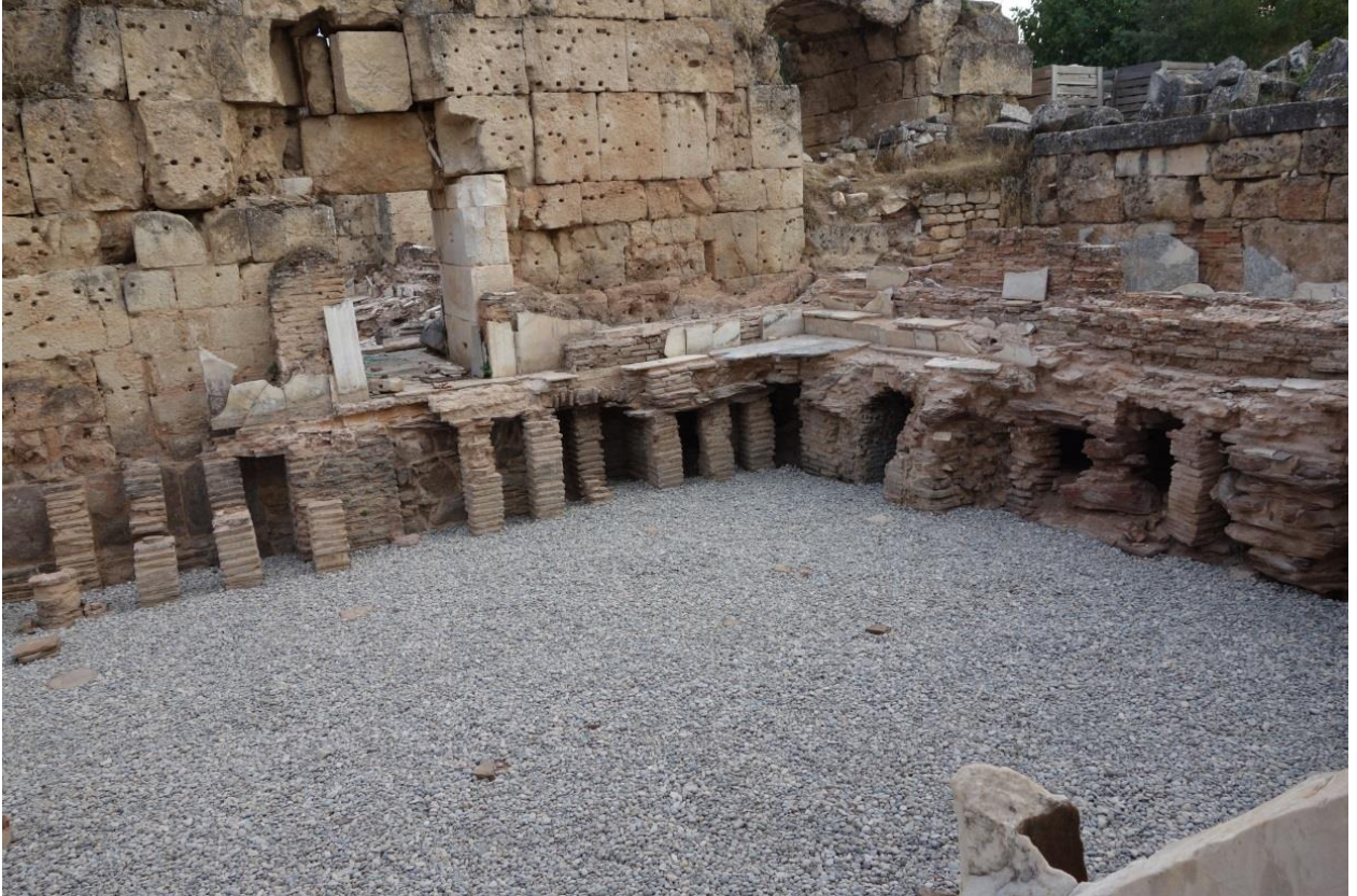
Res. 4-5: Hadrian Hamamı. Oda 5: hipokost'un onarımı ve tabanın jeotekstil ve çakıltaşı ile kaplanması (2014).
