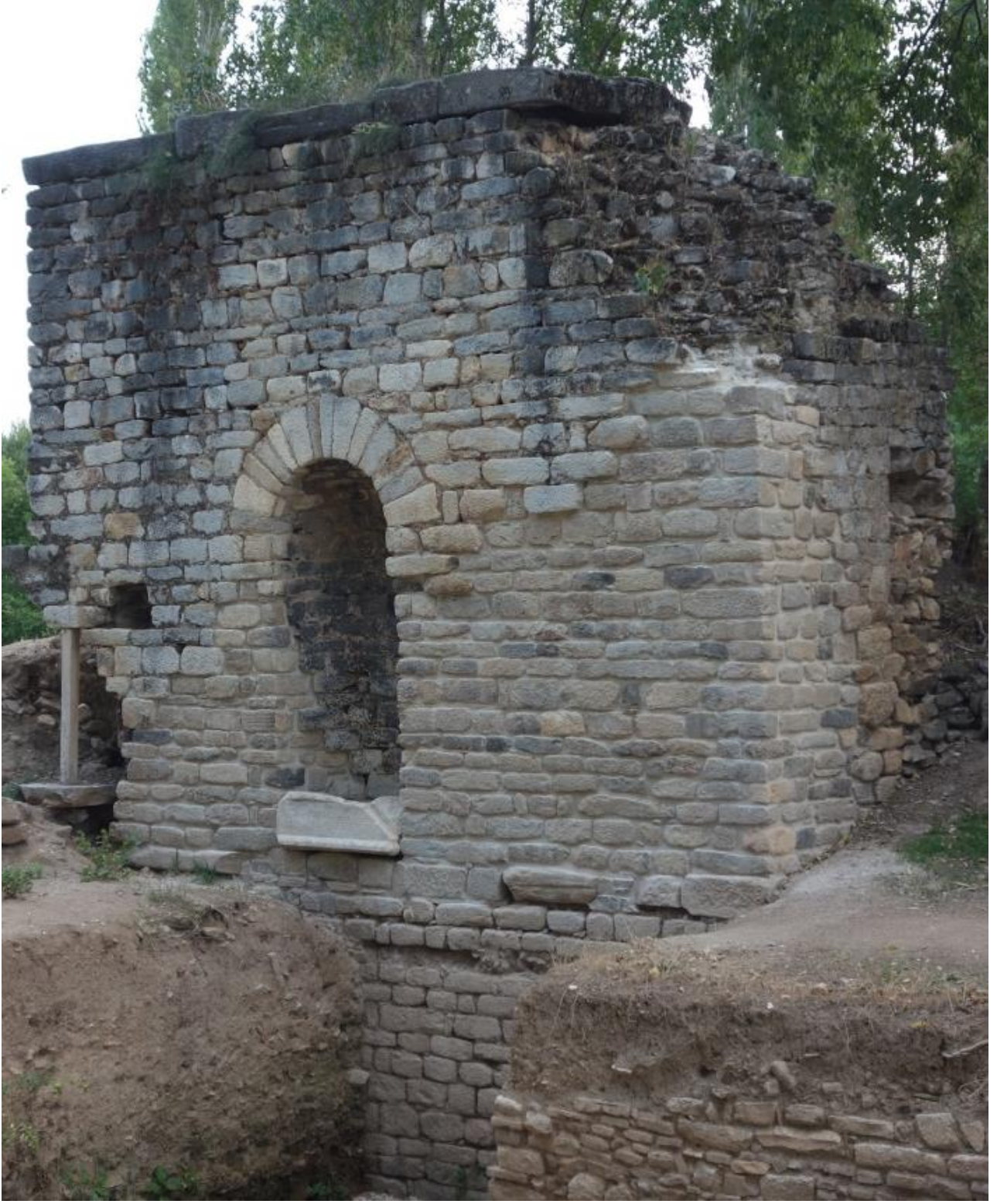
Res. 14: Tetrasyon Caddesi. Nişli yapı, restorasyondan sonra (2014).
