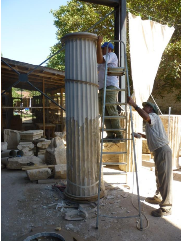
Res. 29-31: Sebasteion Propylon. Sütunların ve payelerin konservasyon işliğinde onarılması (2014).
